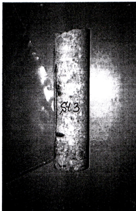
Slika A17: Odvzeti valjni vzorec betona s preglednega mesta St3
