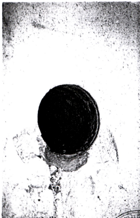
Slika A10: Pregledno mesto St4: mesto odvzema valjčnega vzorca betona
