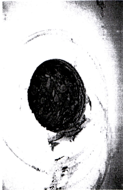
Slika A16: Pregledno mesto St3: mesto odvzema valjčnega vzorca betona
