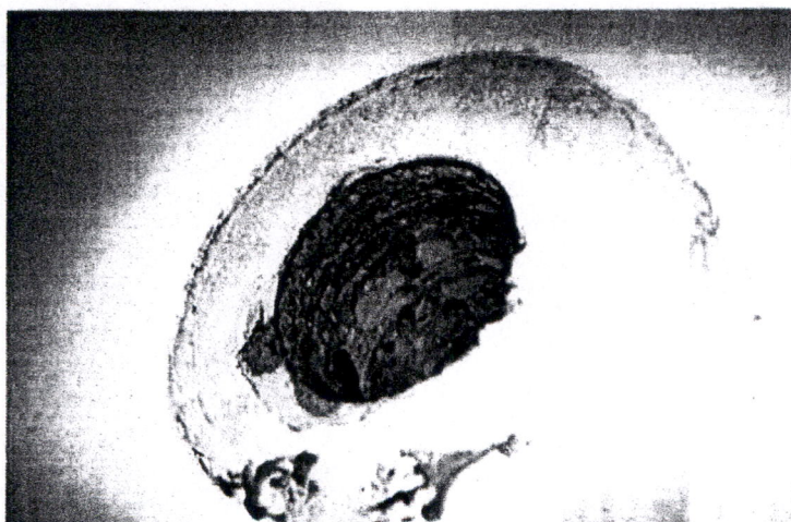
Slika A13: Pregledno mesto St2: mesto odvzema valjčnega vzorca betona
