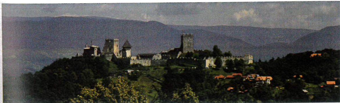
Poleg palacija na levi izstopa po svojem gradbenem volumnu na celjskem Gornjem gradu Friderikov stolp v grajskem središču. 23 m visok stolp z do tri metre debelimi zidovi je bil po svoji funkciji t. i. Bergfried , torej nestanovanjski obrambni stolp, zadnje zatočišče pred napadalci, če bi ti prebili grajsko obzidje. Stolp je dobil ime po Frideriku II., kajti vanj je dal Herman II. Celjski zaradi nedovoljene poroke z Veroniko Deseniško zapreti svojega sina, stražo pa je zaupal vitezu Joštu Soteškemu.
